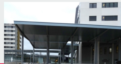
L'hôpital Jean Minjot, situé au coeur du Pôle Santé
