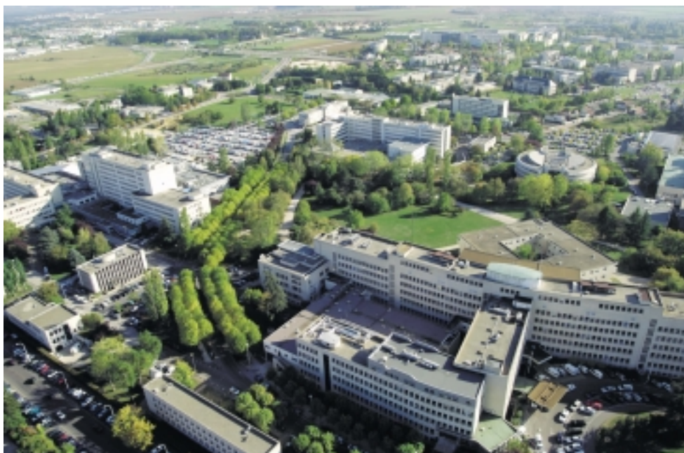
CHU DIJON - Complexe hospitalier du Bocage
