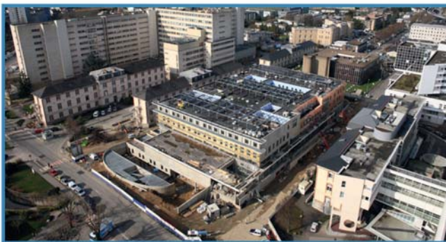
Chantier du CUR - mars 2009
