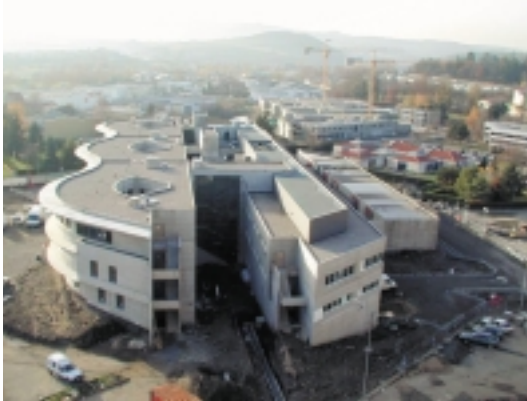
Chantier de l'Institut de Cancérologie de la Loire Architecte : Michel Lassagne
