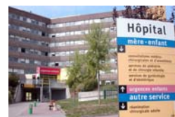
Hôpital de Hautepierre
